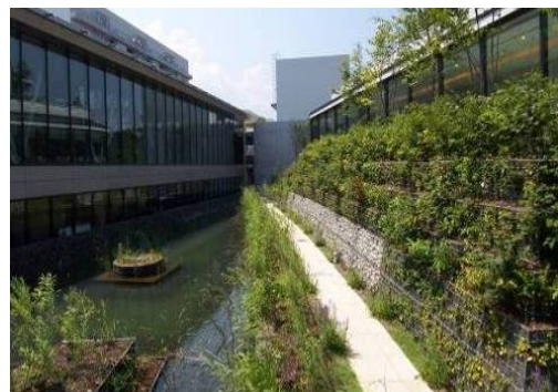
構内の建築物緑化
